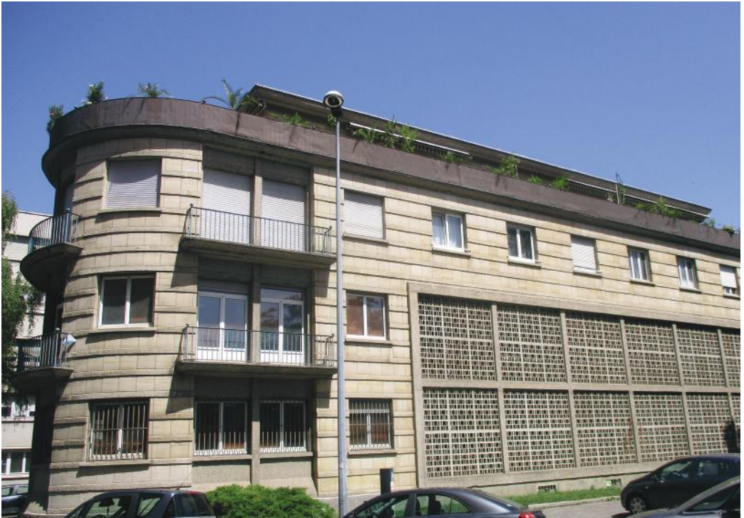
Bâtiment du Comptoir national d'Escompte de Paris, architectes Pierre Jean Guth et Jean Clabaux (cliché de l'auteur)
