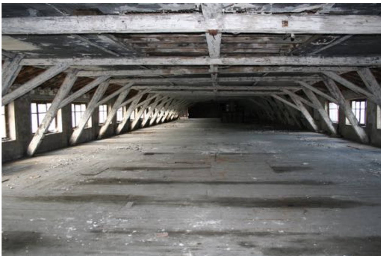
Atelier le plus ancien : ferme de l'étage de combles à surcroît.
