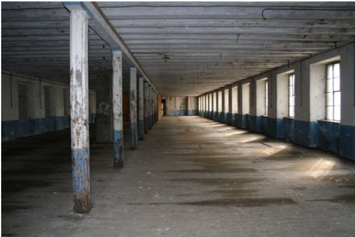
Atelier le plus ancien attesté sur un plan de 1857 : 1er étage. Alignement de poteaux octogonaux en bois. Eclairage latéral assuré par une série de baies rectangulaires, en partie murées à gauche.
