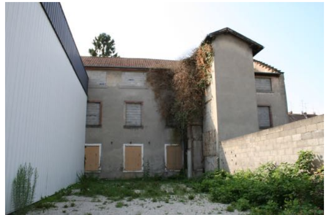
Atelier attesté dès 1857 : façade nord et extrémité ouest correspondant à l'ancienne chaufferie.
